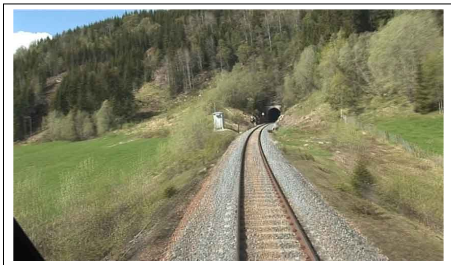
Saltenpendelen går i 130 km/t deler av strekningen Fauske–Bodø og i tunnel fra Røvika til Valnesfjord. Det vil vegutbyggerne kopiere og konkurrere ut jernbanen i stedet for å satse på vegsikkerhet og RV 17. Foto: E. Kantun 20©05.
