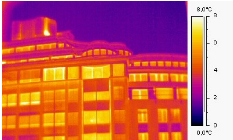
Bilde nr. 1 Taket av bygning R-5, som huser blant annet Arbeids- og administrasjonsdepartementet. Den lyse, vertikale streken helt øverst på taket viser varm ventilasjonsluft fra bygningen som ventileres ut. Ved å installere en varmeveksler på denne luften, vil energiforbruket i bygningen til oppvarming gå ned, og energi kan frigjøres til andre formål.
