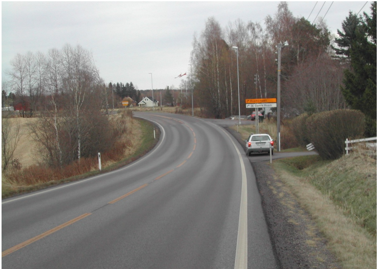
Rv. 2 ved Skulsrud vest for avkjøring til Hvamsmoen i Nes kommune. Foto: Eystein Kvam
