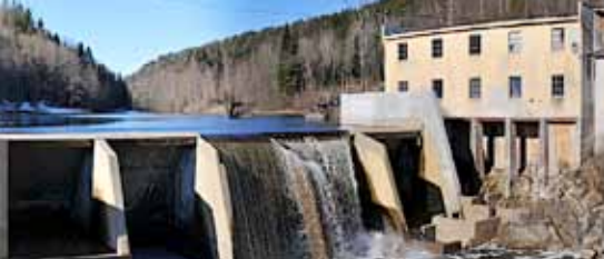
Fosstveit kraftverk i Storelva ved Tvedestrand.
