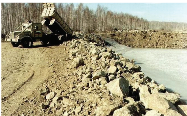
Засыпка озера Карачай, хранилища средне-радиоактивных отходов (ПО «Маяк», ЗАТО Озерск, Челябинской области)
