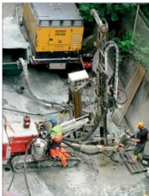
BORING: Et smalt brønn er boret 170 meter ned i jorden. Her utfører Spar Kjøp-bygget. (Foto: Arvid Kallestad)
