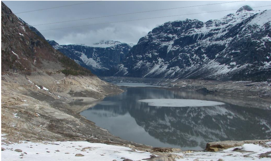
Ringedalsvatnet i Odda er et reguleringsmagasin som er oppdemt av Ringedals-dammen. Vannstanden varierer fra 373 til 464 meter over havet. Det naturlige elveutløpet er helt tørrlagt. Foto: Nils Johan Ystanes
