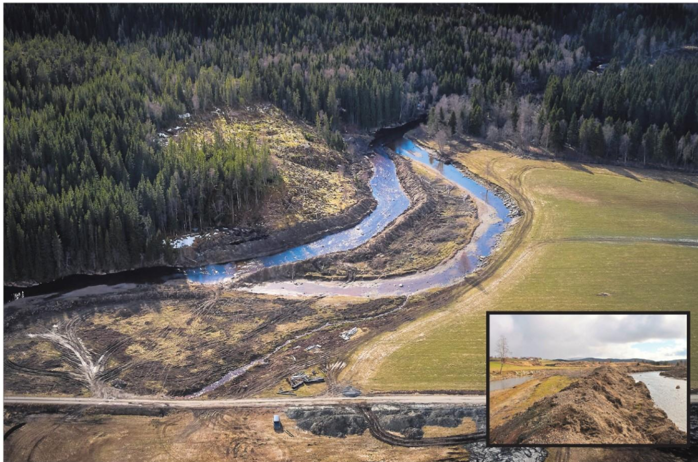
FLYTTET ELVA: Grunneieren har flyttet en strekning av elva på nesten 300 meter. Det gamle elveløpet er stengt igjen, men det er fortsatt noe vann i den gamle kanalen. Nå vil NVE at grunneieren skal rette opp etter seg.
