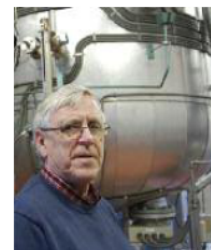
Fabrikkseier Geir Haltbrekken foran dampkjele på Felleskjøpets fabrikk i Trondheim.
