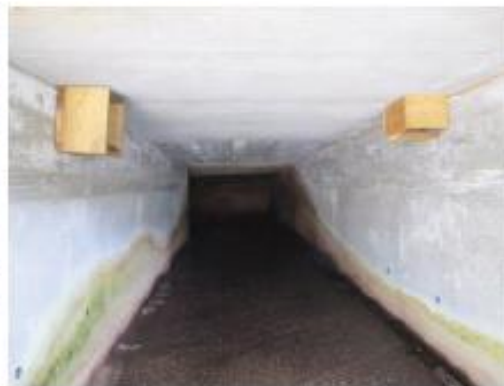
Figur 21. Stor og liten kasse montert i utløpstunnelen ved Bergesli småkraftverk.
