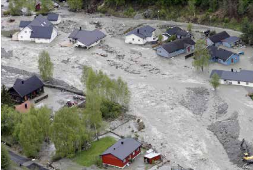
Den ødeleggende flommen i Kvam i 2013 er et signal på "våtere, varmere, villere". Foto: Dagbladet.
