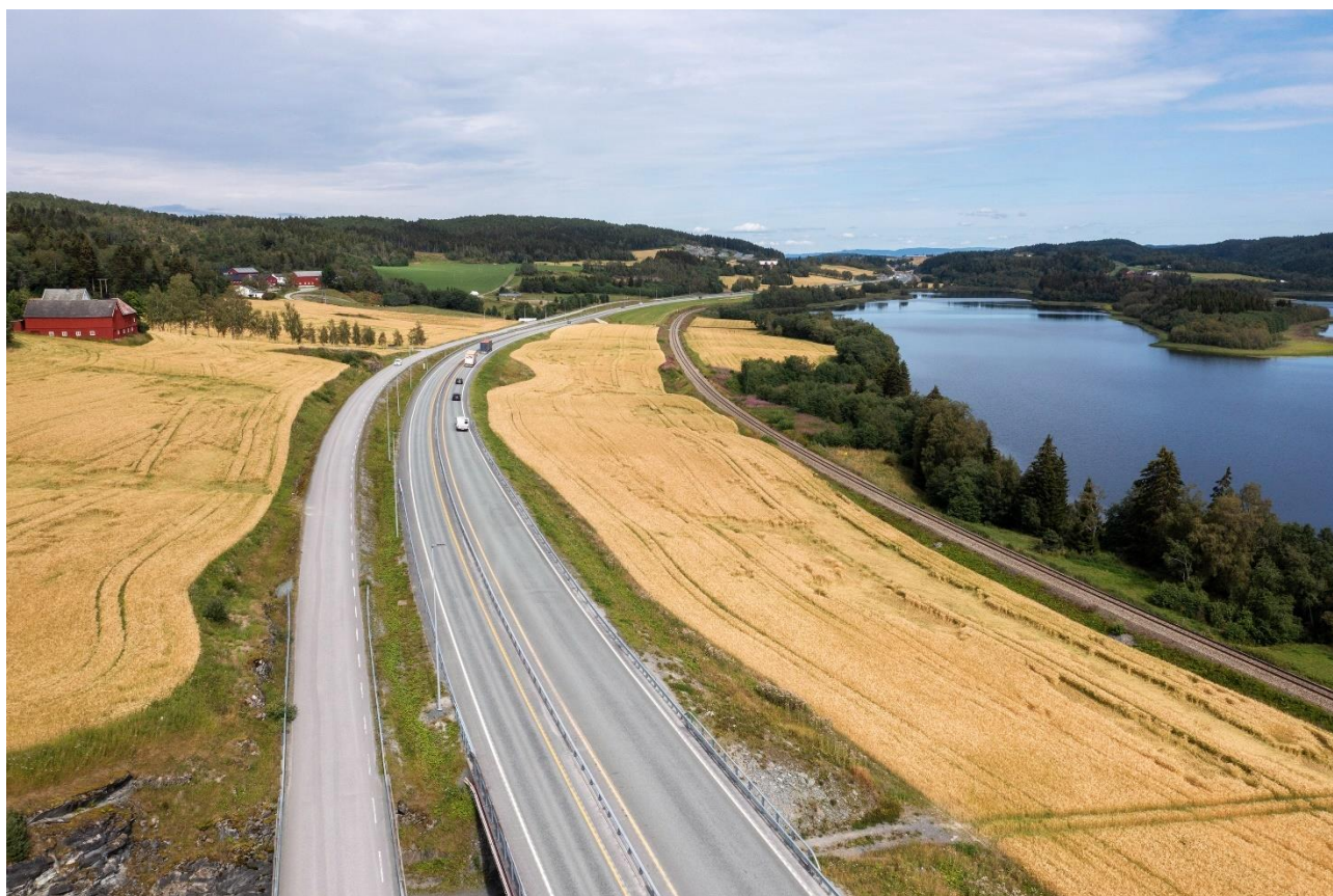
Dronebilde fra dagens E6 nord for Skogn i Trøndelag, som er en trafikk sikker 2/3-feltsvei med midtrekkverk og fartsgrense 90 km/t, modernisert i 2018. Likevel er planen å bygge 4-felts motorvei for 110 km/t.
