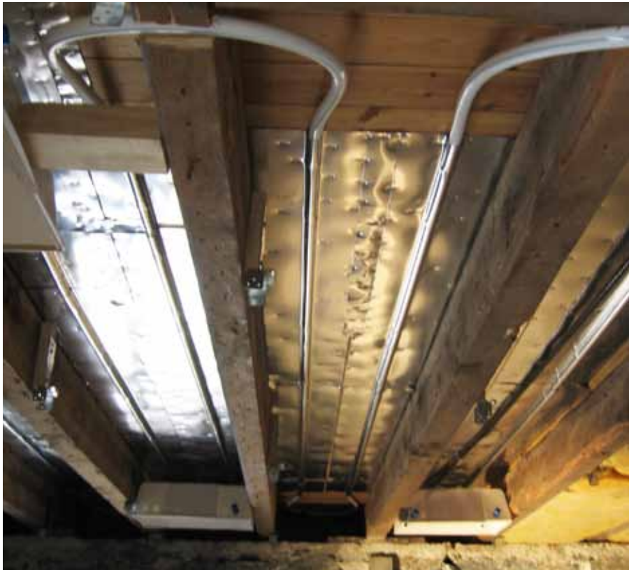
Da familien renocverte kjelleren benyttet de sjansen il å montere vannrør og isolasjon i bjelkelaget mellom kjeleren og ørste etasje. Foto: Privat
