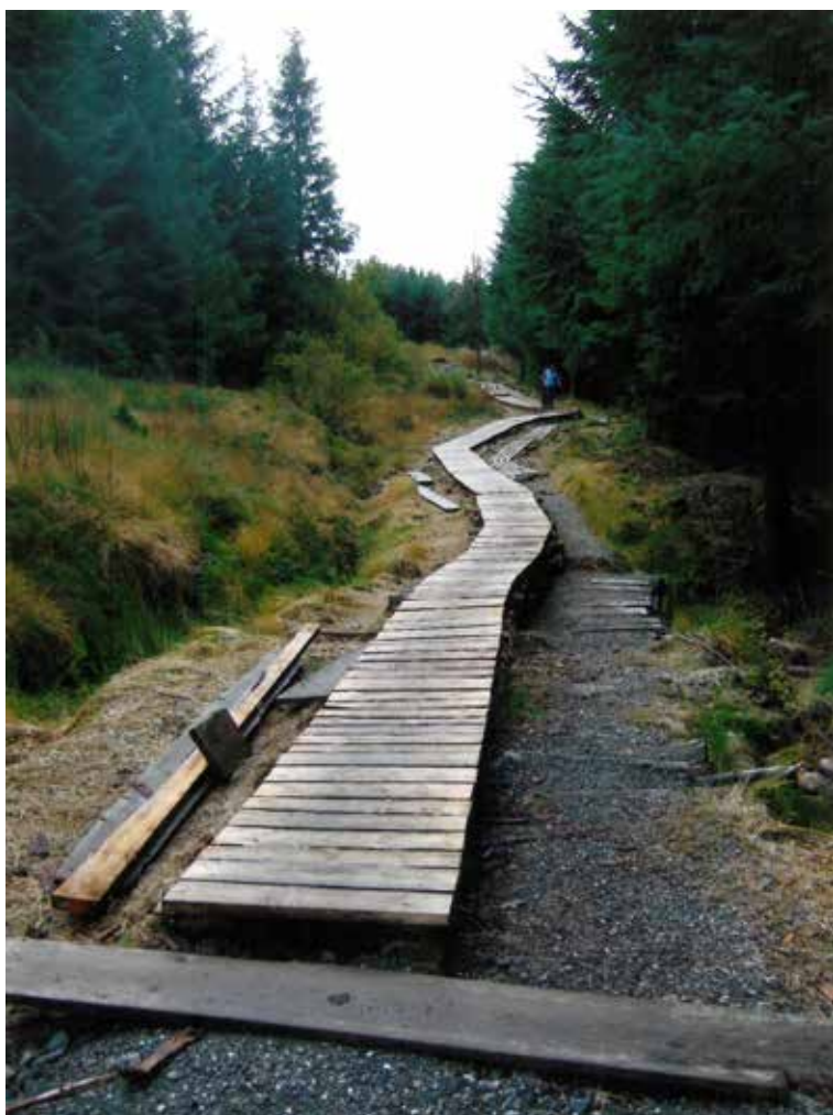
■ Myrbroen på Militærvegen, ferdig 2001.
