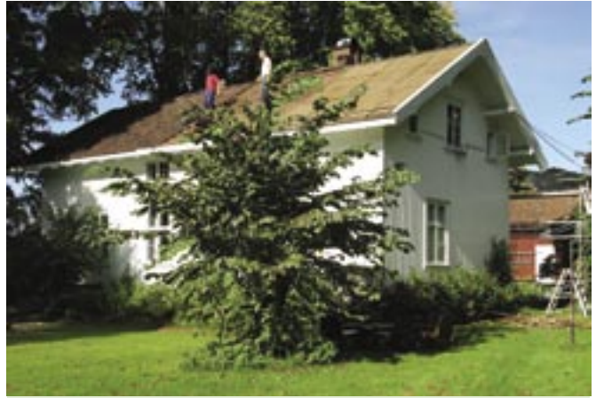
Økriskolen ble åpnet den 23. januar 1866, som en av Bærums første faste skoler. Med godt vedlikehold av bygningsmassen, varer kulturminnene lenge – slik denne skolen har gjort. Økrigata 24 fremstår i dag i store trekk slik den ble bygd i 1866. Foto: Terje Jacobsen
