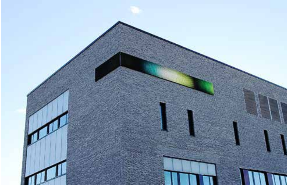
Brynseng skole i Oslo har solcellepaneler på vegger og tak.
