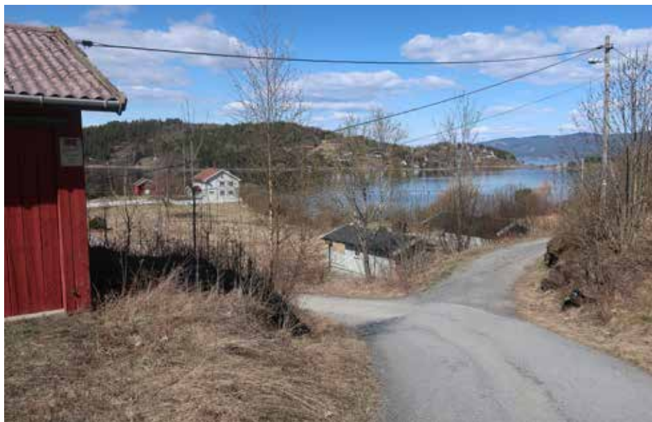
Motorveien vil krysse Kroksund akkurat her, ved nå nedlagte Rørvik camping.
