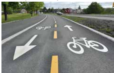
Foto: Knut Opeide, Statens vegvesen
