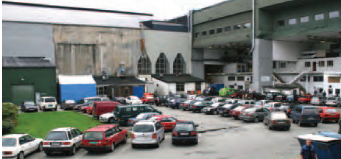
Disse bilene står på området der tre ubåtdokker er gjenfylt ved ubåtbunkeren på Laksevåg. Nå vil målinger vise om grunnen her avgir PCB til fjorden, slik at alt må graves opp. (Foto: Trond Olav Skrunes, Sydvesten)
