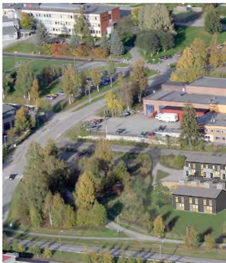
I "Passivhusene" som skal bygges i Smestadlundens borettslag vil behovet for oppvarming være redusert til en femtedel.
