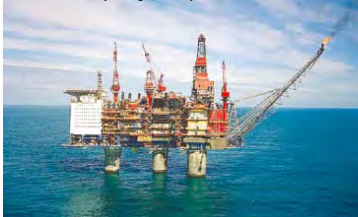
Gullfaks C var blant oljeplattformene som brukte brannskum med PFOS, men nå har fasen det ut. (Foto: Øyvind Hagen, StatoilHydro)
