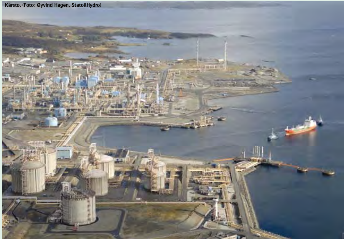
Kårstø. (Foto: Øyvind Hagen, StatoilHydro)
