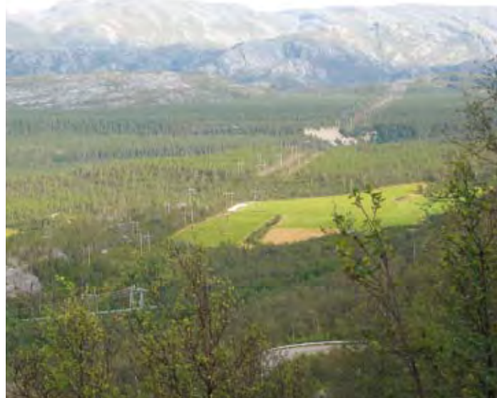
Her i Kvænangsbotn vil den nye linjen følge den eksisterende kraftlinjen som vises på bildet, men den nye linjen vil bli langt større. (Foto: Statnett)
