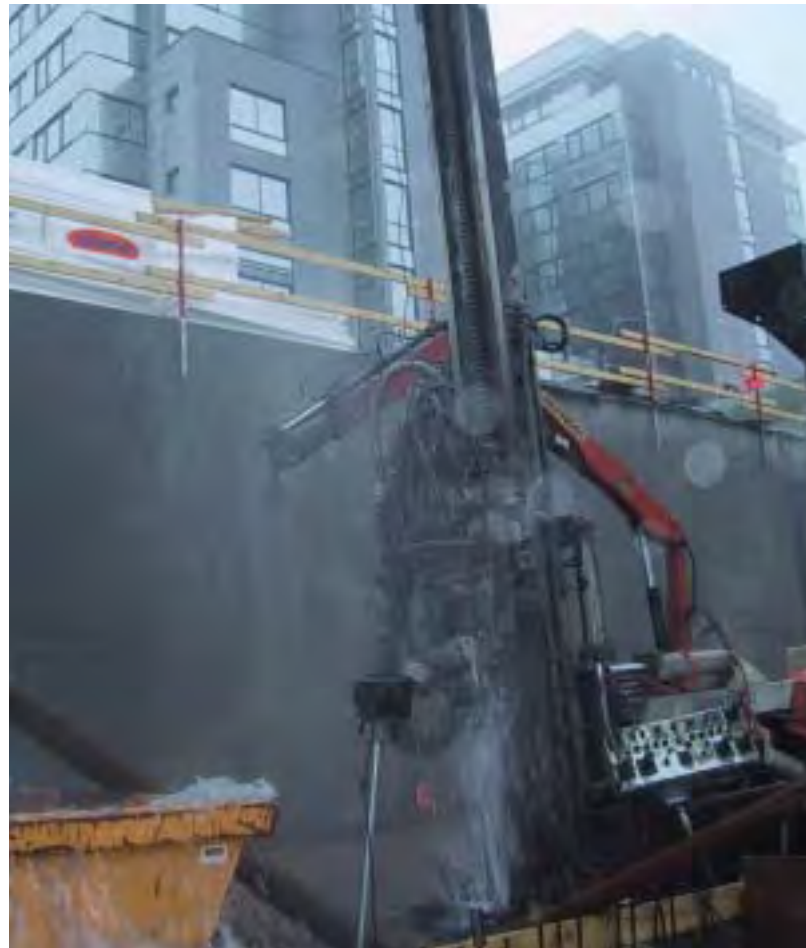
Geotermisk varme kan bli en av fremtidens store varmekilder. Her fra bygging av anlegget i Nydalen i Oslo. (Foto: Geoenergi AS)
