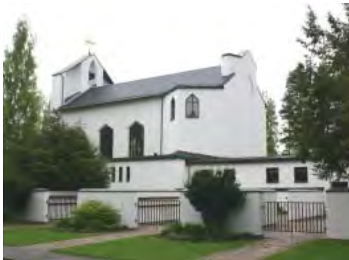
Her, ved kapellet på Skogskyrkogården i Jönköping, skal anlegget for frysetørring av døde bygges, sannsynligvis til neste år. (Foto: Kristian S. Aas)
