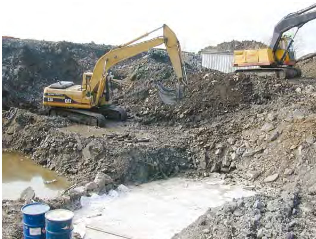
Utgraving og opprydding av en gammel avfallsfylling der Telenor nå har bygget på Fornebu. Forsatt gjenstår en lokalitet på Fornebu som ikke er oppryddet. (Foto: Statsbygg)
