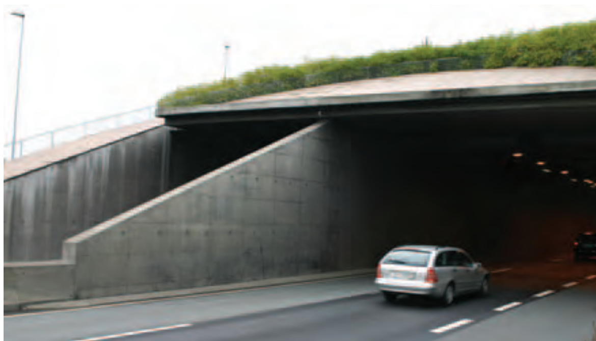
Tåsentunnelen på Ring 3 i Oslo er en av vegutbyggingene som har blitt finansiert gjennom vegpakker. (Foto: Kristian S. Aas)
