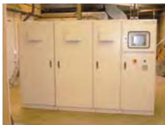
Denne maskinen ved Karolinska universitetssjukhuset i Huddinge i Sverige sørger for å bryte ned lystgassen til nitrogen og oksygen. (Foto: Showa Denko)
