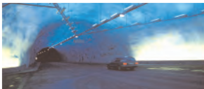
Lærdalstunnelen: Åpnet i 2000, verdens lengste biltunnel. Et resultat av samme stortingsvedtak. (Foto: Audun Garberg)
