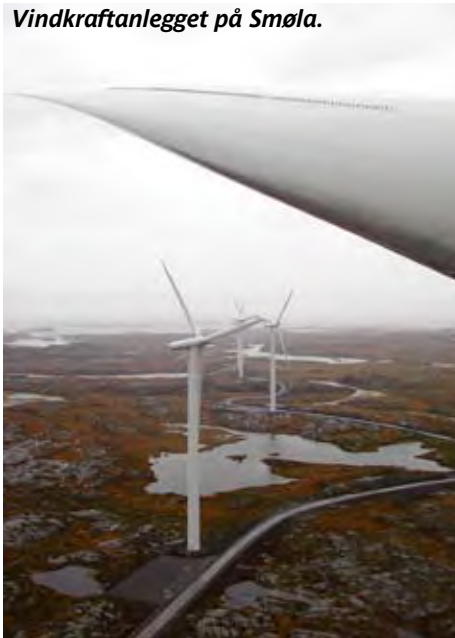
Vindkraftanlegget på Smøla.
