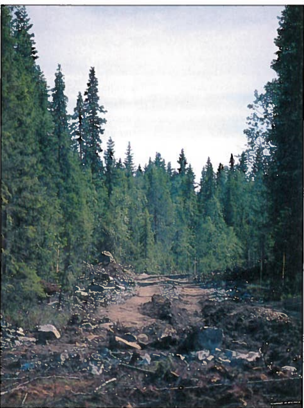
MOTORVEI-TRASÉ I MARKA: Et tett løypenett skjærer seg på kryss og tvers gjennom marka. Løypetrassene er opp til ti meter brede. Noen av dem skal asfalteres etter OL. (Foto: Prosjekt Miljøvennlig OL)
