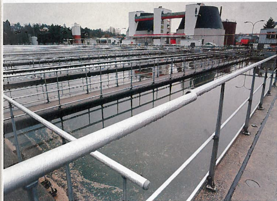
Rekken av bassenger er lang. Her skal slammet få tid til å synke.
