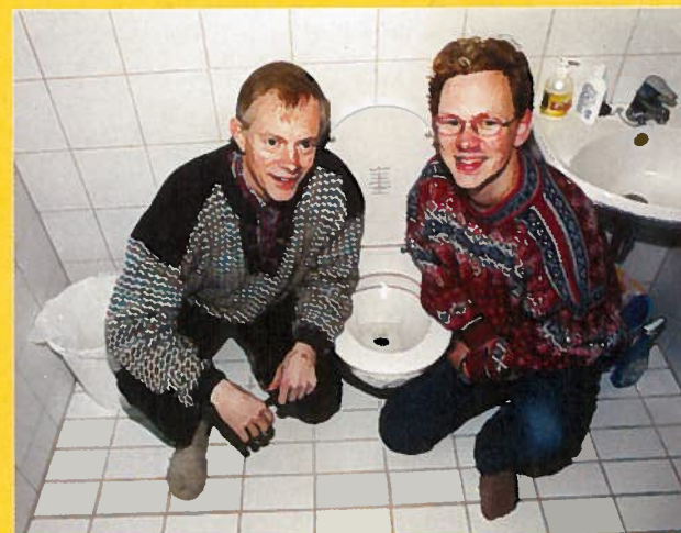
Vakumtoalettene på studenthjemmet bruker 1 liter vann per spyling, og holder toalettvannet adskilt fra resten av avløpsvannet. Petter Jenssen og Erling Søyland har tro på løsningen.
