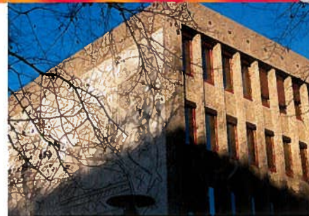
Pablo Picassos kunstverk skjuler en kraftig energilekkasje. Etasjeskillene er som en kuldebro som slipper ut varme.
