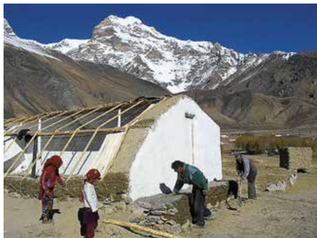
Bygging av isolert drivhus i fjellregionen Pamir i Tadsjikistan. FOTO: INTERNASJONAL AVDELING
