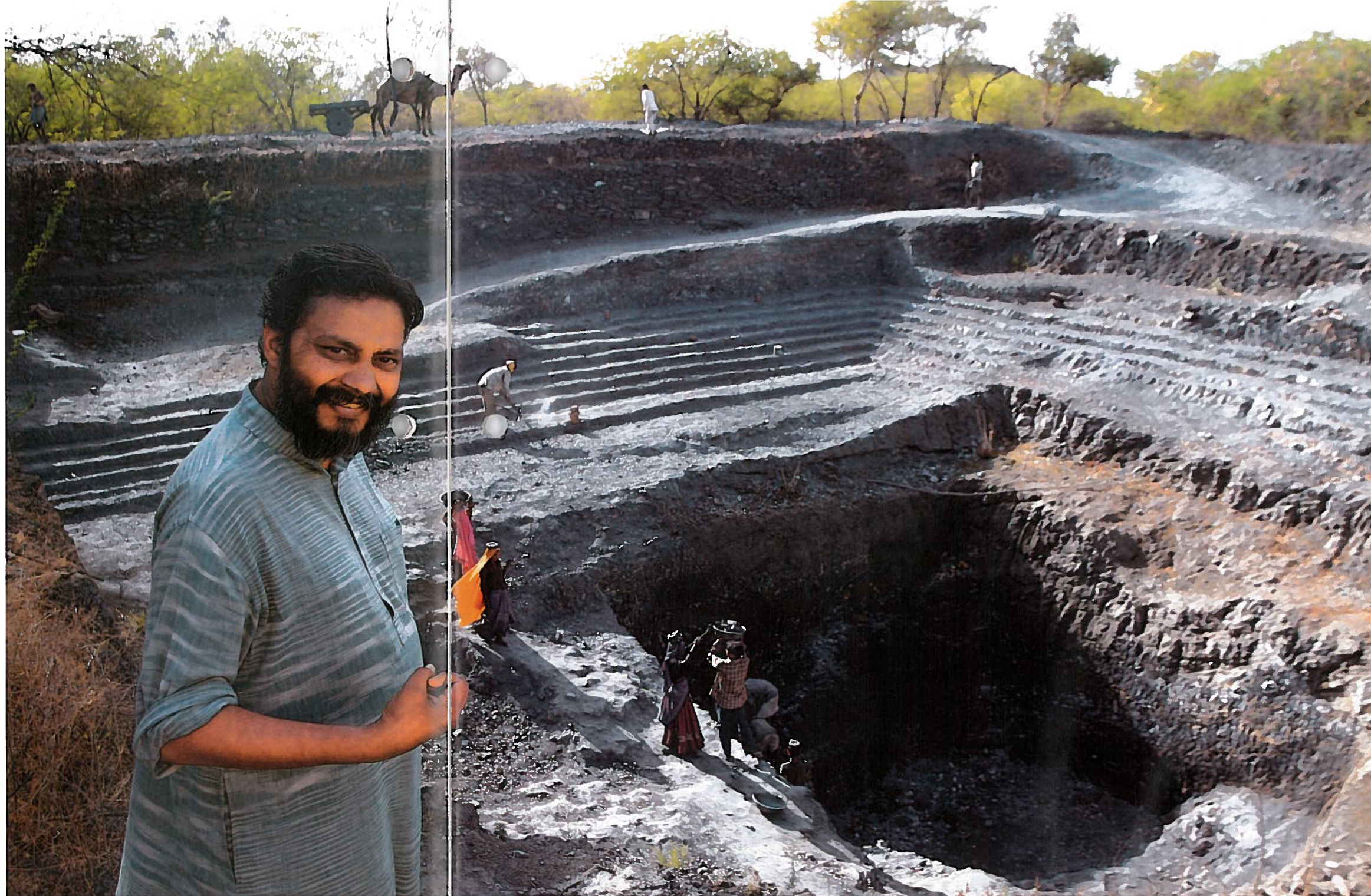
I full sving med å bygge et nytt anlegg for å samle opp regnvann.
