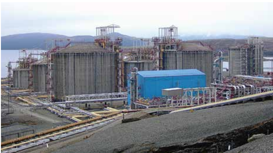
Gasskraftverket på Kårstø var gjenstand for en årelang kamp. Nå er det stengt ned fordi det ikke er lønnsomt lenger.
