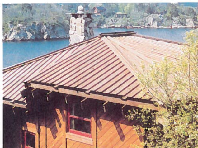
Tak av tre er gammel byggetradisjon i Norge.
