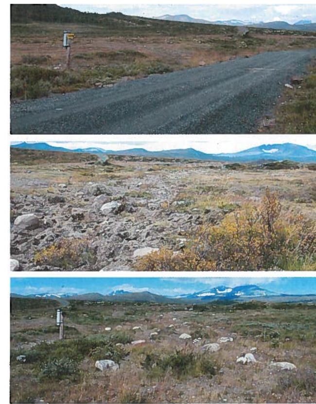
Rehabilitering – tilbakeføring til naturen. Bildene viser fjerning av veg i Hjerkinnskyte- og øvingsfelt. De to øverste bildene viser vegstrekingen før og etter anleggsarbeid i 2002. Nederst viser resultatet tre år senere, i 2005. Foto: Odd- Erik Martinsen, Forsvarsbygg
