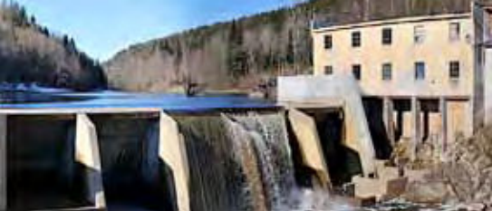
Fosstveit kraftverk i Storelva ved Tvedestrand.
