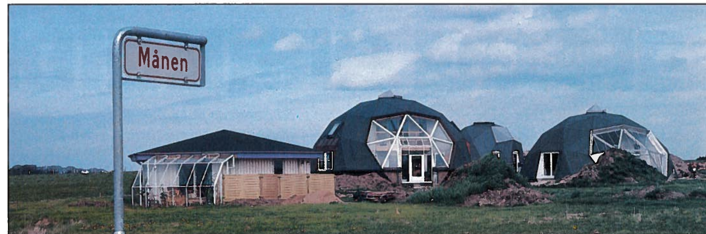
KULEHUS: De kuleformede husene på «Månen» har et gunstig forhold mellom volum og overflate med tanke på energitap. Husene er sørvendt, og mot nord et det lagt opp en isolerende jordvoll mot veggen. (Foto: Mads B. Nakkerud)
