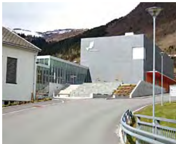
... og Operahuset Nordfjord varmes opp av energi fra fjorden.
