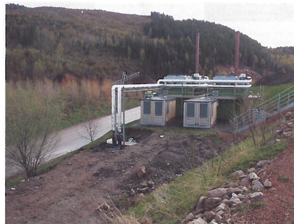
Utslippene av drivhusgassen metan er kraftig redusert i Drammen. Årsaken er dette anlegget for oppsamling og forbrenning av metan ved Lindum avfallsdeponi.
