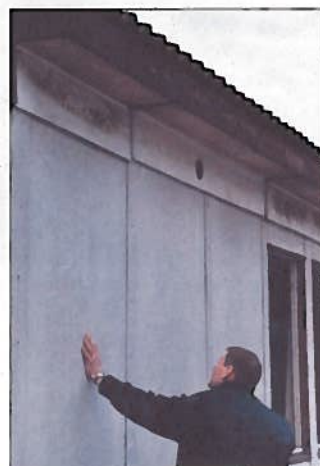
Asbestholdige plater er normalt ikke farlige med mindre de skades, bearbejdes eller utsettes for påkjenninger under riving eller reparasjonsarbeid.
