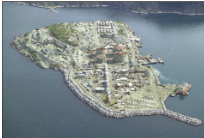
Gasskraftverket på Melkøya utenfor Hammerfest kan bli ilagt CO 2 -avgift på nærmere 300 millioner kroner årlig. (Foto: Statoil)
