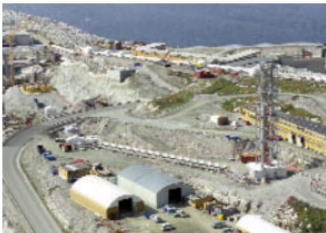
Gasskraftverket som bygges i forbindelse med Snøhvit blir ilagt CO 2 -avgift. Nå strides regjeringen om nye gasskraftverk også må betale avgift. (Foto: Statoil)
