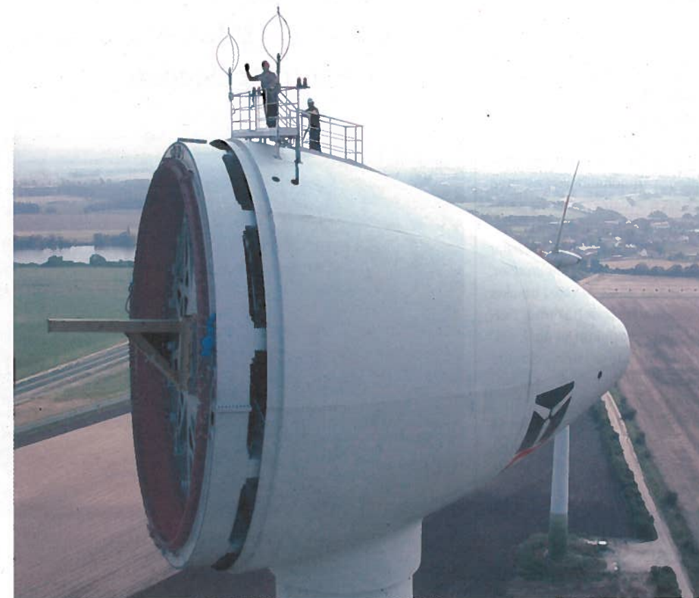
Tyskland leder an i vindkraftutviklingen, og ønsker et mål å strekke seg mot. Møllen i Magdeburg er ett av mange prosjekter. 4,5 megawatt strøm skaffer denne rotoren.
