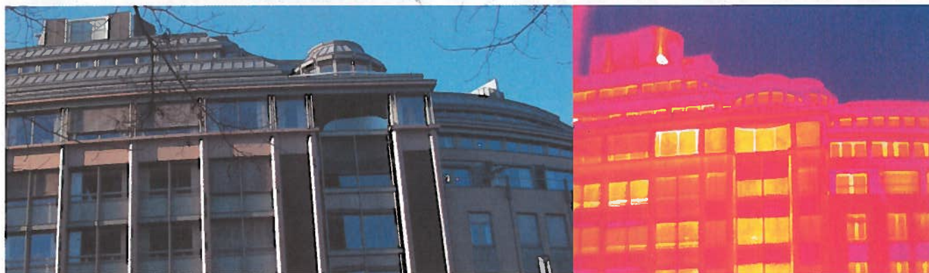
De lyse feltene i bildene til venstre viser at energi lekker fra inngangsparti og tak. — På taket mangler varmeveksler for å håndtere energien. Her renner skattepengene ut, sier generalsekretær Tore Killingland i Naturvernforbundet.
