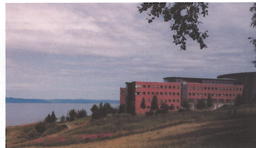
Strømforbruket til belysning ved Statoils forskningssenter på Rotvoll i Trondheim er redusert med 80 prosent.
