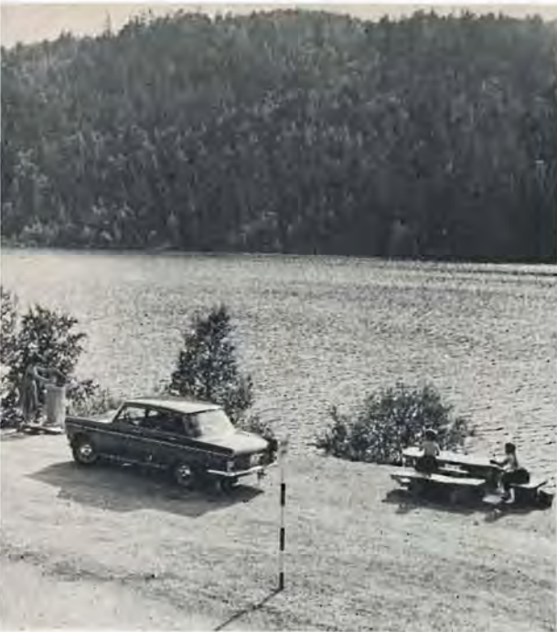
Mønsergyldig rasteplass ved veien i Atnedalen. Nedenfor: Steinmasser fra tunnelarbeider i Nedalen som fundament for ny vei. Foto R. F.
