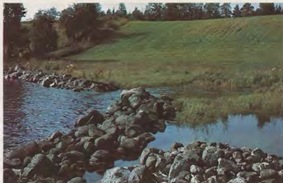
Matjord forsvinner årlig på sjøen. Forbygging mot erosjonen med stein hjelper lite fordi landet innenfor synker på grunn av grunnvannsvariasjonene.
