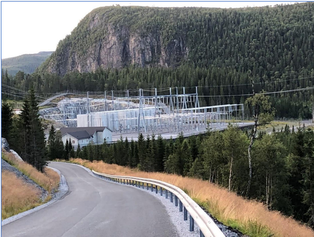
Figur 15 Trafoanlegget på Hofstad i Roan ligg der det før var ei myr. Minst 5 meters tjukk torvjord er køyrt bort, i tillegg er berg sprengt i bakkant. Vegen ned til trafoanlegget går gjennom ein borealregnskog, og denne var registrert på kart. Mange gongar blir verdfull natur øydelagt utan at ein var klar over at den var der, utan at den var registrert. Her var verdien kjent. Foto: Kari Merete Andersen.
