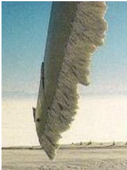
Figur 23 Is på finsk turbinvinge 59 .
