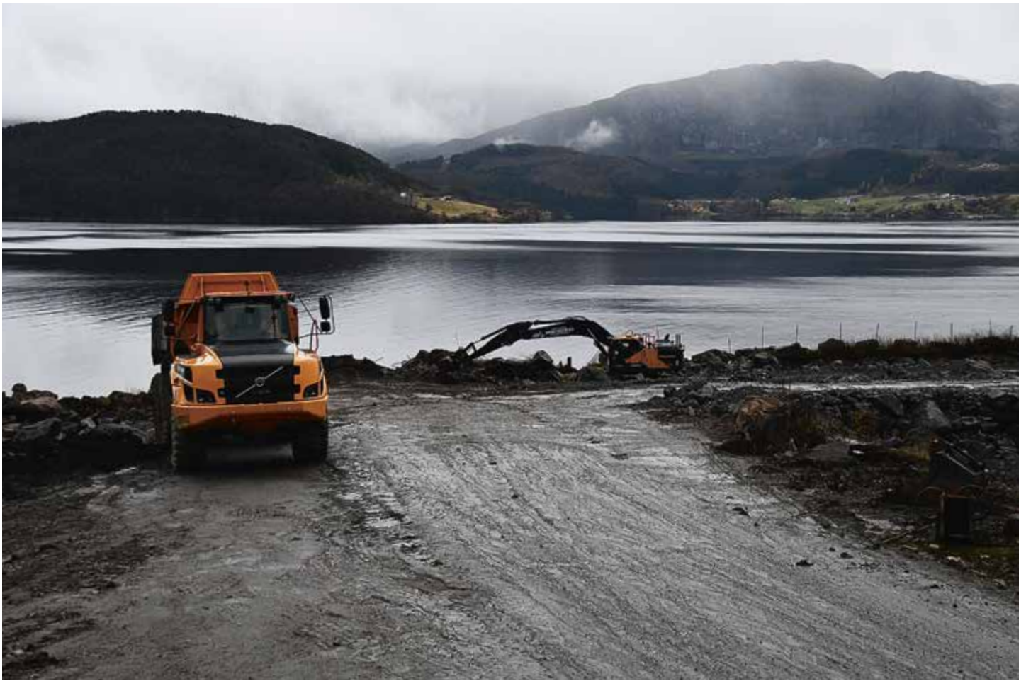
Nordic Mining klargjør tomten på Engebø for bygging av gruveanlegg.
